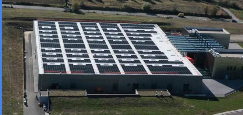
Case-study1: Video centrale fv su capannone 367 kWp sistema fisso
