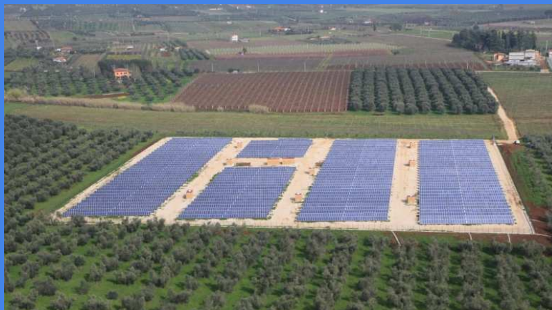
Case-study2: Video centrale fv 1 MWp ad inseguimento solare monoassiale: http://www.youtube.com/watch?v=lq1jWoCQWDI
